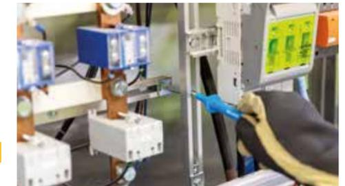
Messleitung mit **Prüfspitzen (ohne Sicherung)** und 2-Leiter-Messung direkt auf Stromschiene
