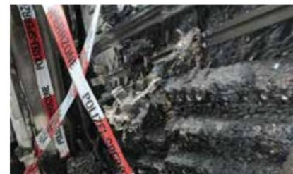
Verkohlte Hauptverteilung, verbrannter PVC.-Leitungsschutzschalter mit verbrannten PVC-Abdeckplatten.
