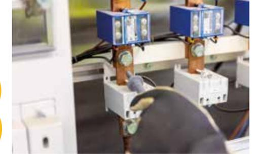
Messleitung mit **Prüfspitzen (mit Sicherung)** und 2-Leiter-Messung direkt auf Stromschiene
