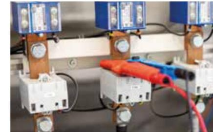
Messleitung mit **Kelvinklemmen** und 4-Leiter-Messung direkt auf Stromschiene
