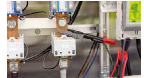
Messleitung mit **Krokodilklemme** und 2-Leiter-Messung direkt auf Stromschiene
