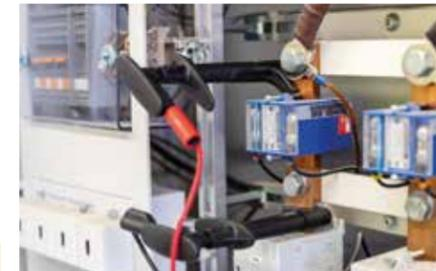
Messleitung mit **Druckfederklemmen** und 4-Leiter-Messung direkt auf Stromschiene
