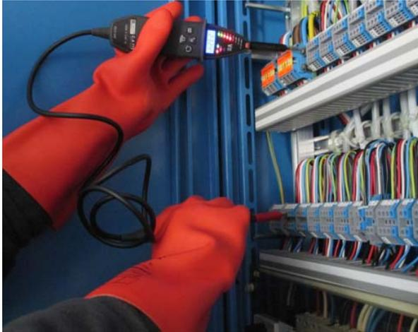
Sicherheitsregel 3; „auf **Spannungsfreiheit**“ prüfen, mit einem Messgerät das den nachfolgenden Anforderungen entspricht:
