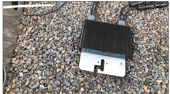
Abbildung 5: Leistungsoptimierer (Optimizer) unter PV-Modul
