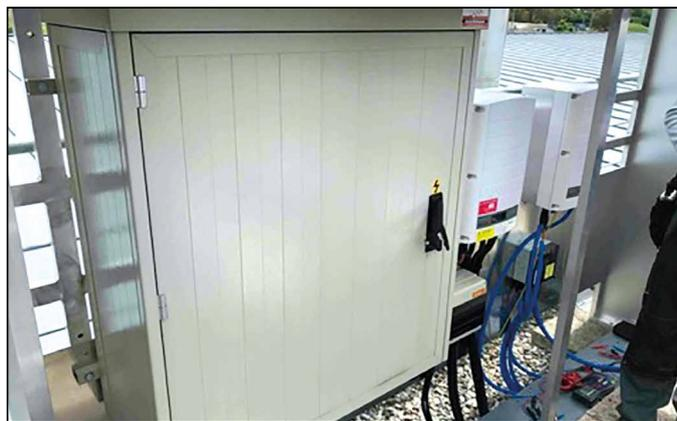
Abbildung 1: falsche Kennzeichnung (NIN 5.1.4.1), fehlende Bezeichnung AC-Sicherung auf Wechselrichter, abgehende Stringleitungen sind nicht bezeichnet
