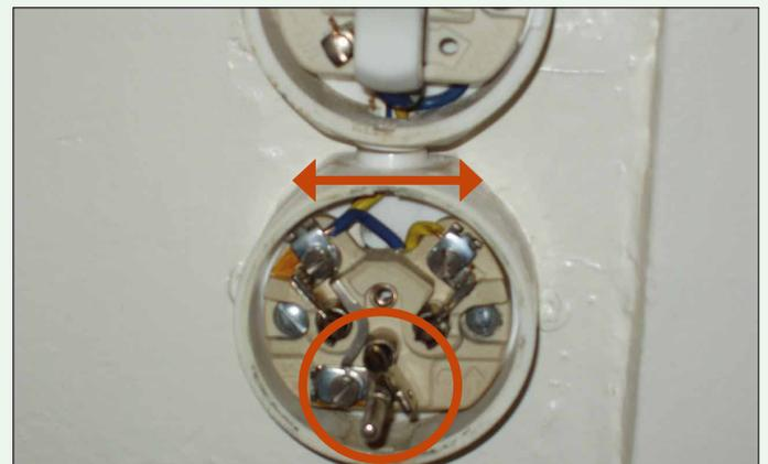
Figura 1: dispositivo d'innesto T14 conduttore polare - conduttore neutro scambiati nella messa al neutro secondo lo schema III, tramite il ponte N-PE il PE è adesso sotto tensione
