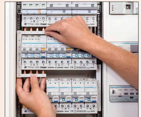
Bei der quickconnect-Anschluss-technik werden Leitungen und neu auch Phasenschienen zur Verdrahtung einfach eingesteckt. Das erhöht die Anlagensicherheit gegenüber
