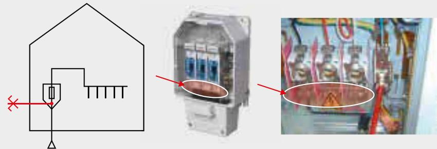
Bild 1 «Normalfall»: Anschlussüberstromunterbrecher, 1 Hausanschlusskasten.
