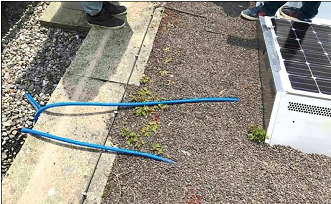
Abbildung 2: falscher Rohrtyp (UV-Beständigkeit NIN 5.1.2.2) und falsche Befestigung bzw. fehlender mechanischer Schutz (NIN 5.1.B.4)
