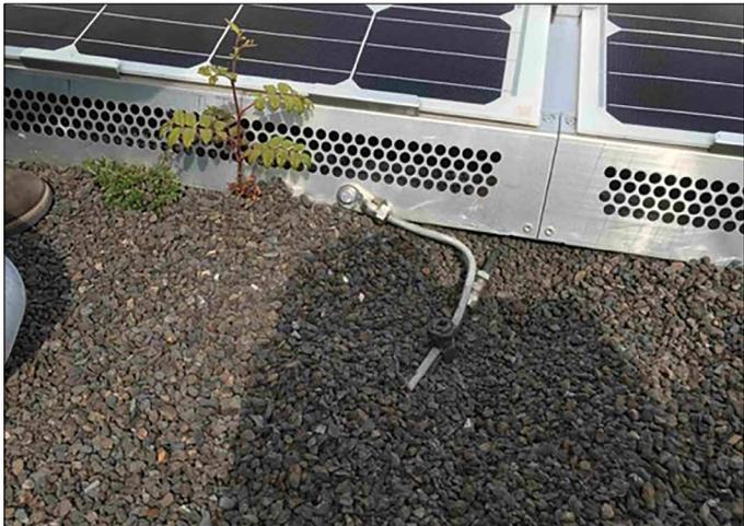
Abbildung 3: falsche Materialwahl, edles Kupfer Metall und unedles Stahl Metall miteinander verbunden, die Folge könnte Kontaktkorrosion sein
